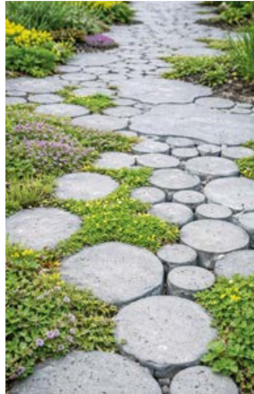
Beispiel „Fugenbepflanzung im Versickerungspflaster“ mit speziellem Saatgut bei der „Stadtoase Ahrweiler“
