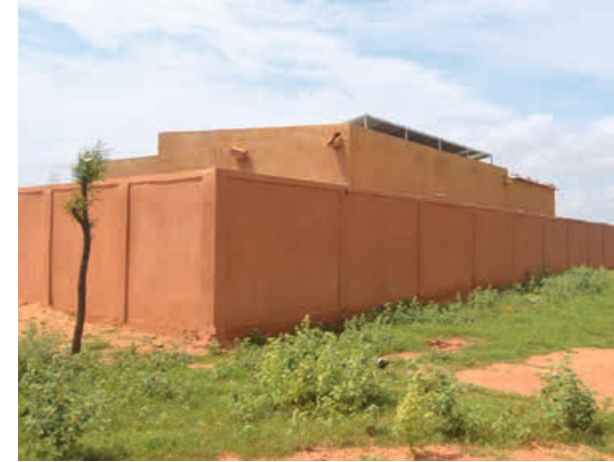
Außenansicht der Milchsammelstelle
