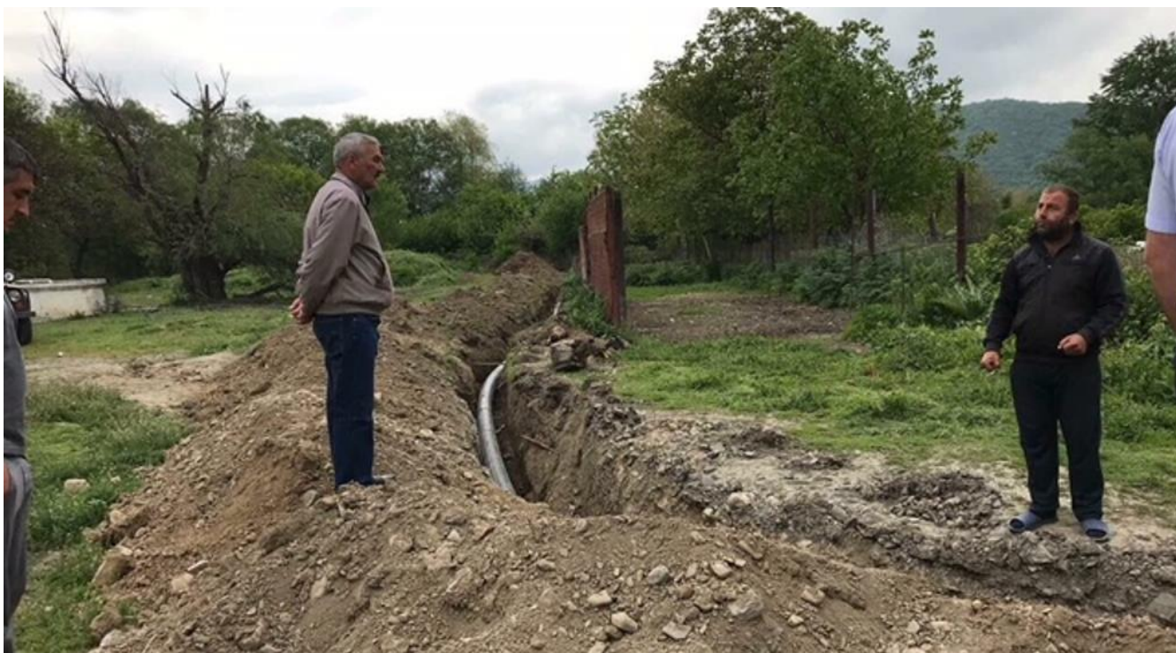
Verlegung der neuen Wasserleitungen
