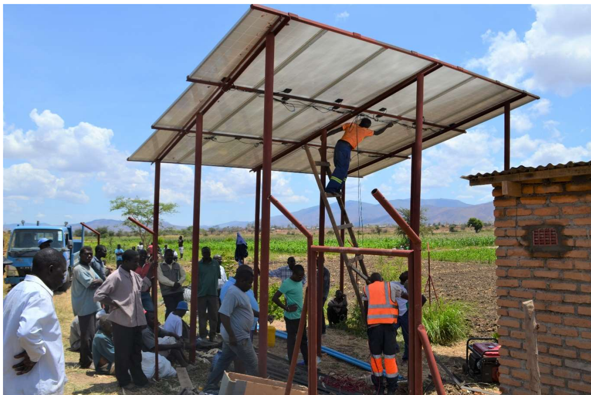
Installation der Solarpaneele für die Bewässerungsanlage.
