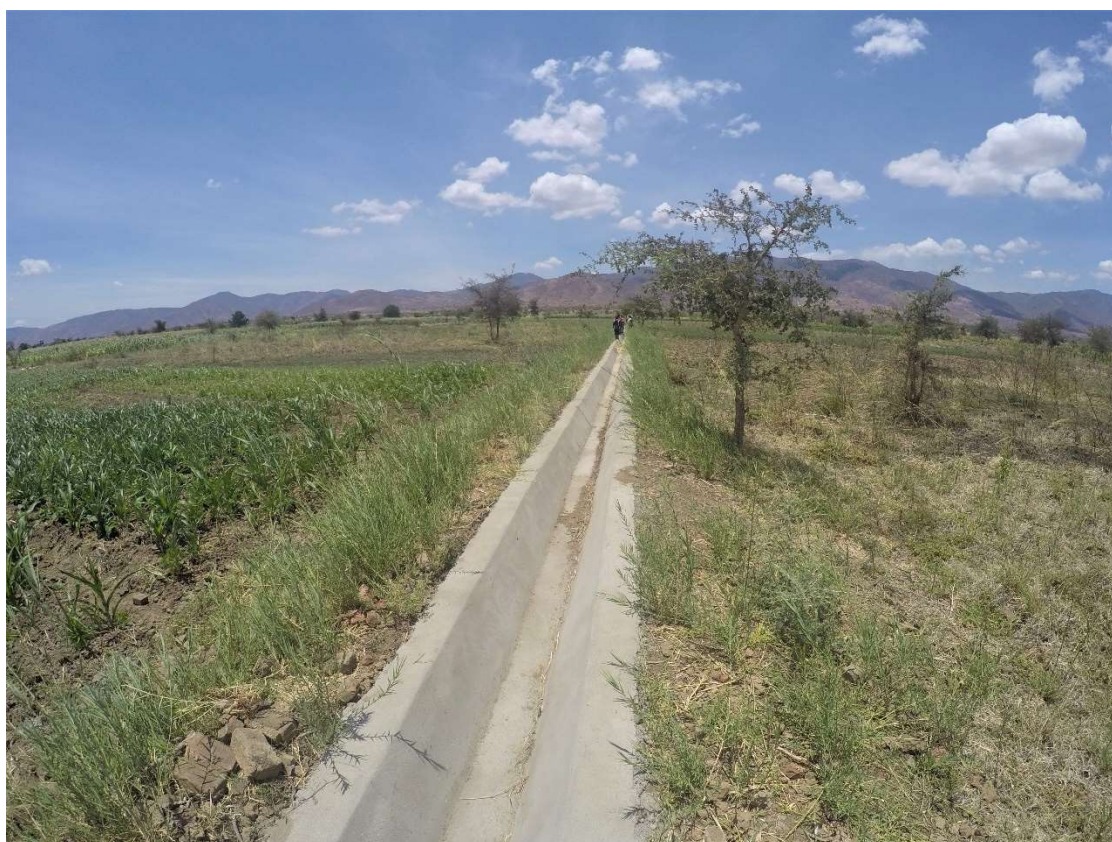
Einer der neu gebauten Bewässerungskanäle.
