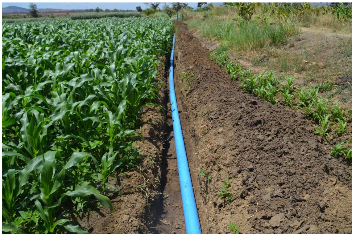
Bewässerungsschläuche wurden rund um die Felder installiert.
